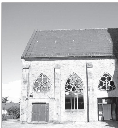
Das neue Pfarrheim liegt ebenerdig im Seitenschiff von St. Dionysius Nordwalde.
